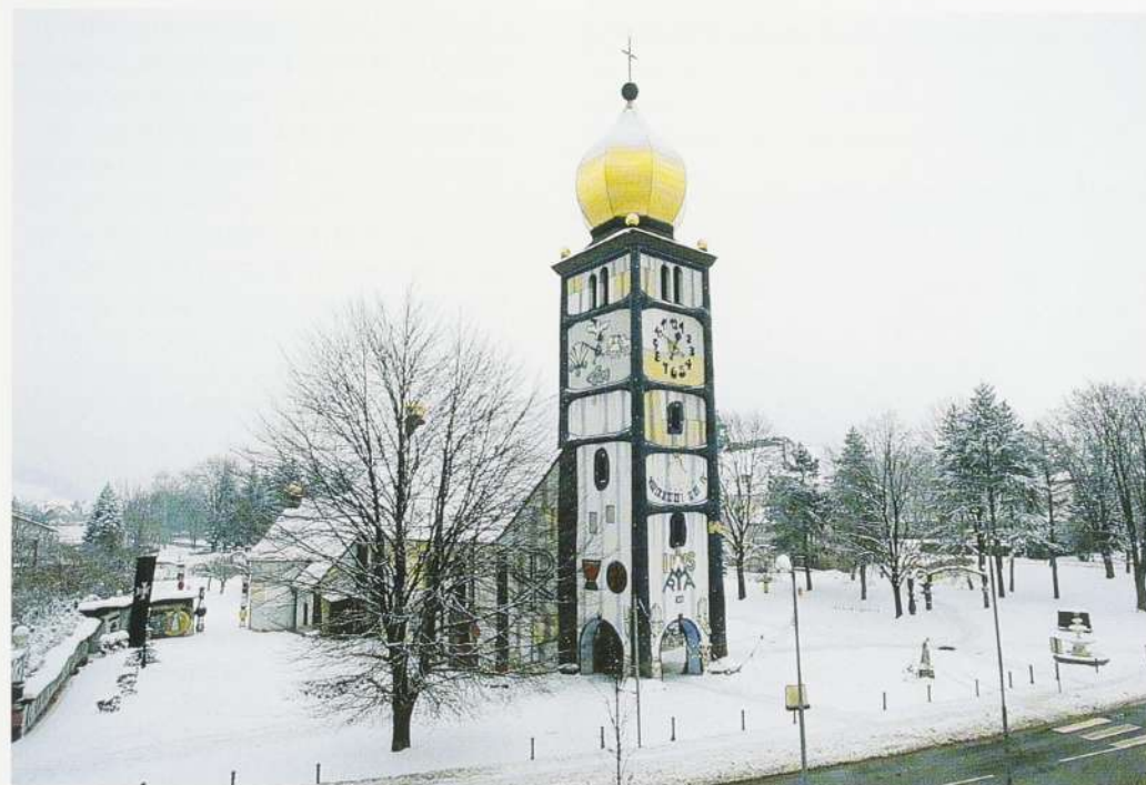
... und nach der Umgestaltung
