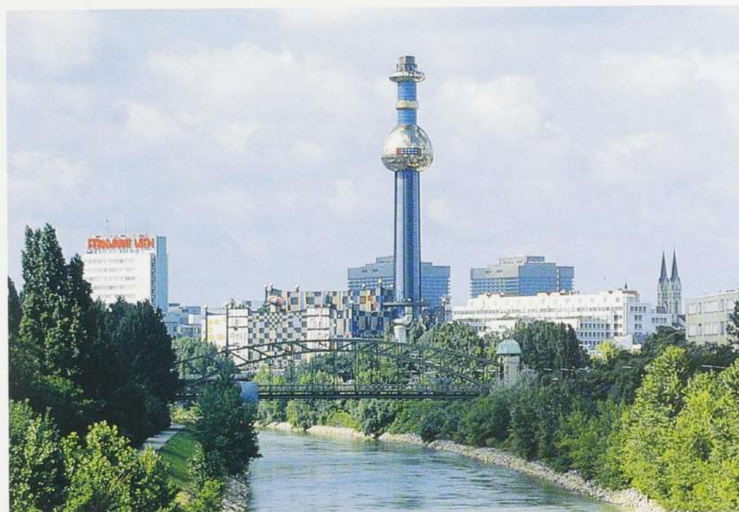
Fernwärmewerk Spittelau, 1988 – 92: Ansicht vom Donaukanal
