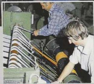
In wochenlanger Handarbeit werden die farbigen Kettfäden auf die Webmaschinen aufgezogen.
